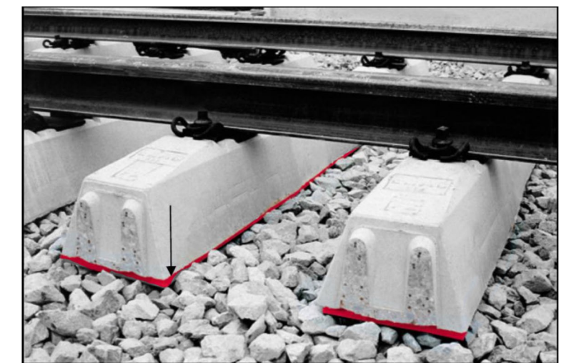
Umístění USP v konstrukci železniční dráhy
