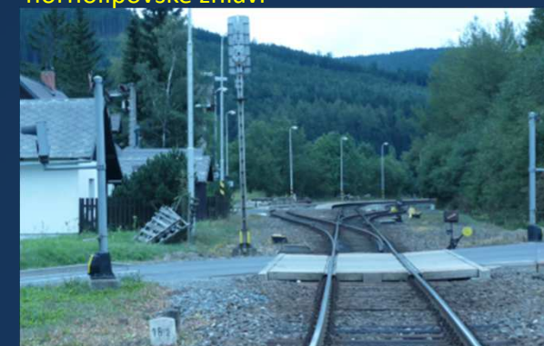
Fotodokumentace – žst. Ostružná, hornolipovské zhlaví
