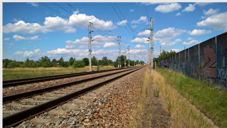
Pohled na zkušební úsek ve směru staničení /červen 2015/
