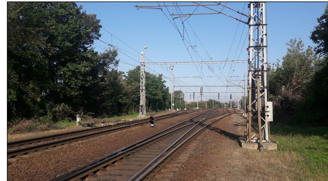
Pohled na stávající břeclavské zhlaví
